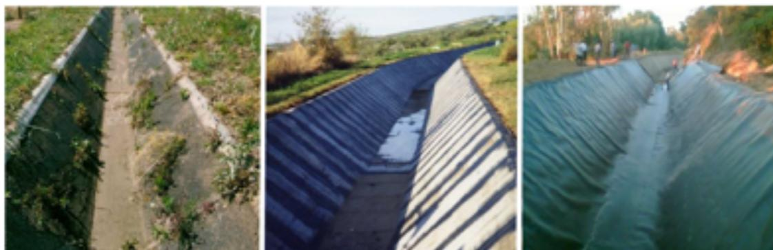
**Figura 18 - Canal de betão antes e depois da aplicação de membrana betuminosa com aditivo anti-raízes, e troço de canal a ser revestido com membrana de polietileno (PE) (Morgado, 2008).**
