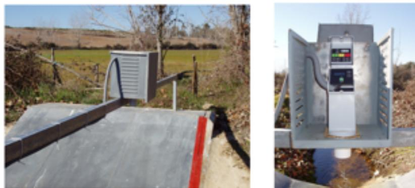
**Figura 24 – Sensor de ultra-sons dirigido para a superfície do escoamento numa estrutura hidráulica (descarregador) para medição de caudais (Duarte, 2006).**
