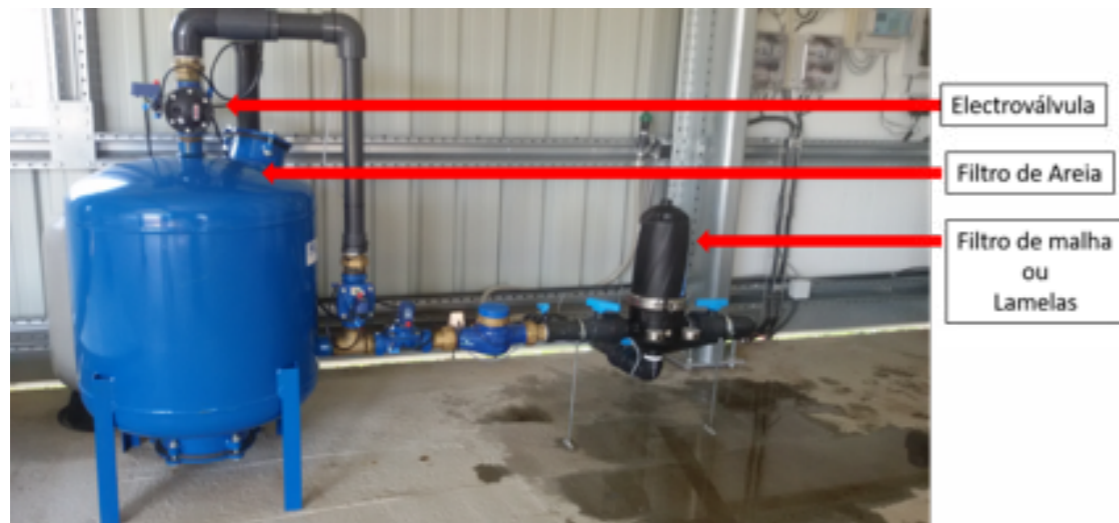
Figura 2.7 – Cabeçal de rega composto por filtro de areia e filtro de lamelas
